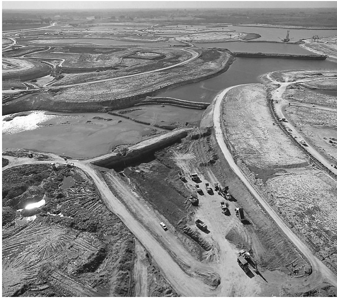
Figura 7.6 – Construcción de grandes rellenos y del lago central de Nordelta.
