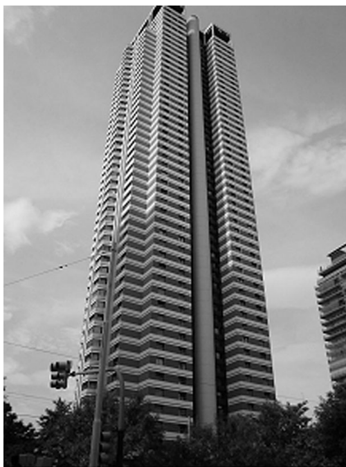
Figura 7.3 – Torre Le Parc.
