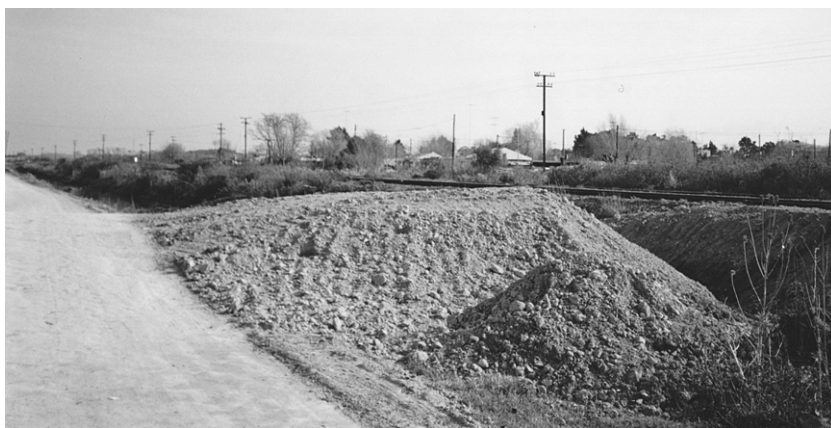
Figura 5.4 — Campana. Barrio San Cayetano. Construcción obra de defensa del PPI. Terraplén sobre calle Lavezzari en intersección con calle Ahumada. Fuente: foto tomada por las autoras.
