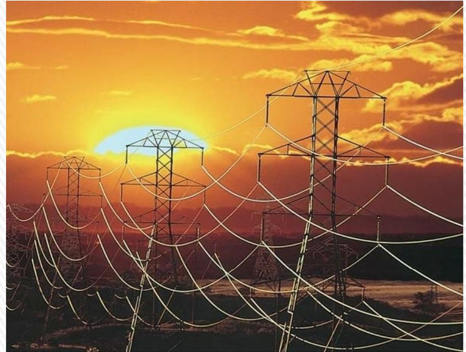
Líneas de transmisión eléctrica transportan energía a hogares e industrias. La energía se transfiere a un voltaje muy elevado, hasta de cientos de miles de volts. Si bien es peligroso, el elevado voltaje origina una menor pérdida de energía, debido a la resistencia en los alambres.
