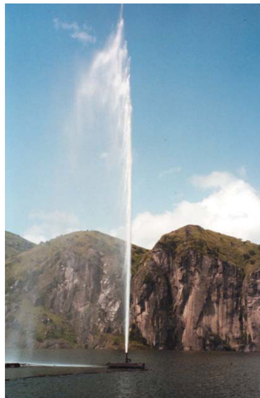
Las aguas profundas del lago Nyoos se bombean hacia la superficie para extraer el \text{CO}_2 gaseoso disuelto.
