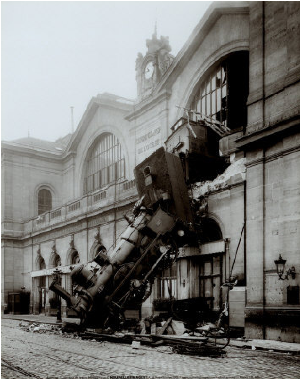
Accidente acontecido el 22 de octubre de 1895 en la estación de Montparnasse, Francia, provocó que una locomotora de vapor que hacía la ruta Granville-París, después que sus frenos fallaran, atravesase la fachada.
