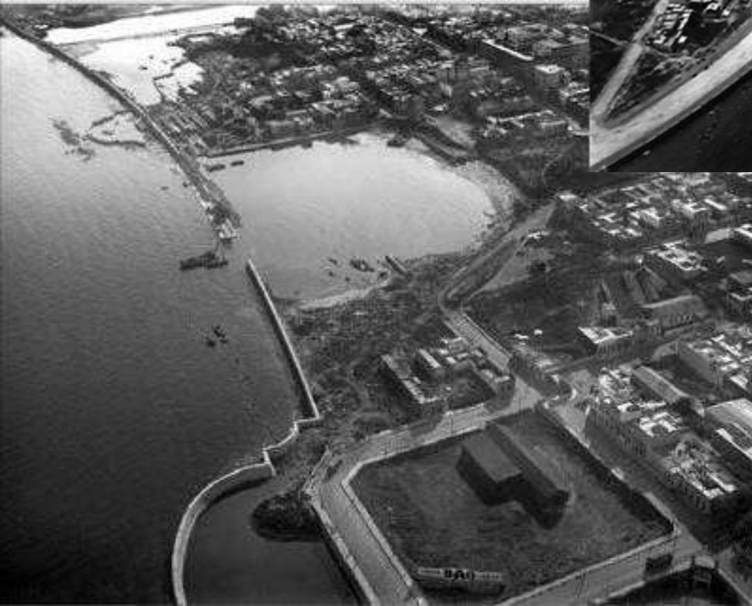
En construcción hacia 1930. Consistió en 4.000 metros, su construcción se realizó sin respetar la forma de la costa ni las dos playas existentes, e insumió unos 500.000 m<sup>3</sup> de arena y piedra.
